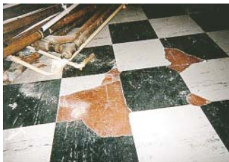
Dalles de sol
