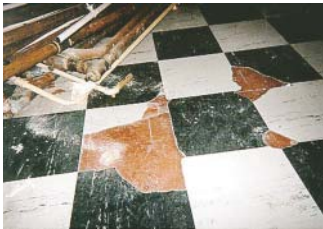
Dalles de sol
