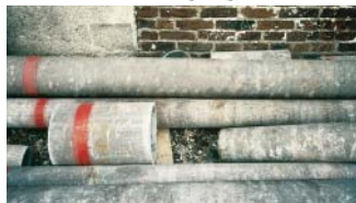
Canalisation en amiante-ciment
