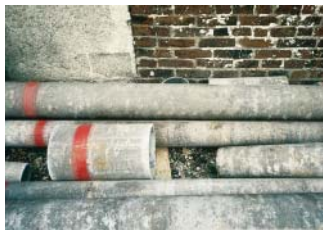
Canalisation en amiante-ciment
