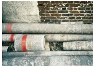
Canalisation en amiante-ciment
