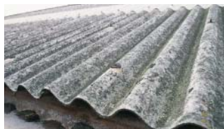
Toiture en amiante-ciment
