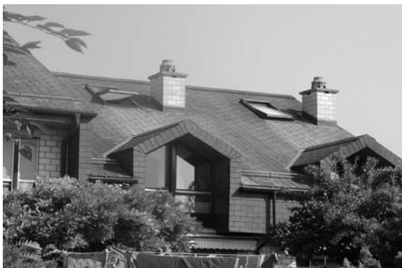
Tuiles en fibrociment, photo IST
