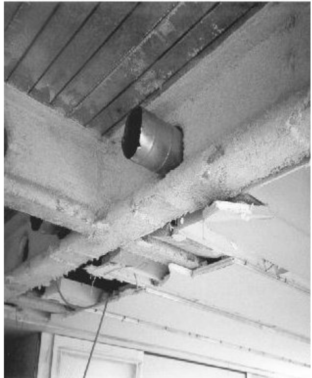
Flocage d'une structure métallique, photo IST
